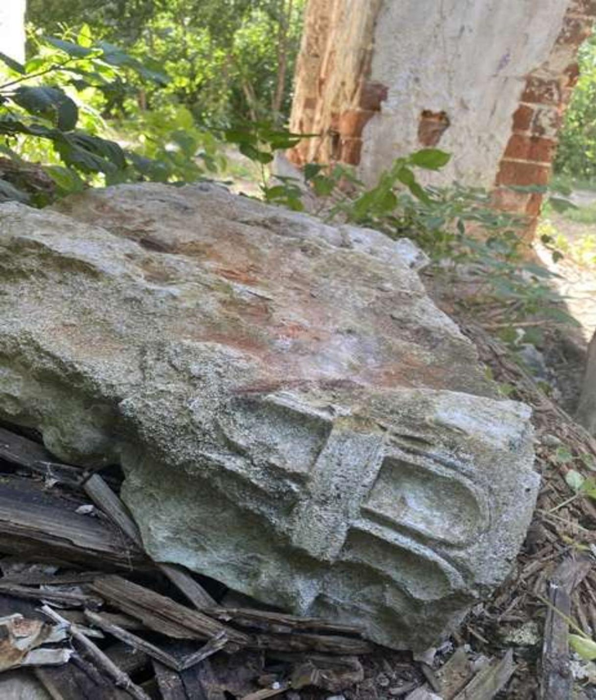
Так как известняк относится к разновидности осадочных карбонатных пород, то он подвержен биоповреждениям. Чем выше пористость, тем больше известняк накапливает влагу в себе, которая способствует развитию разрушений.
